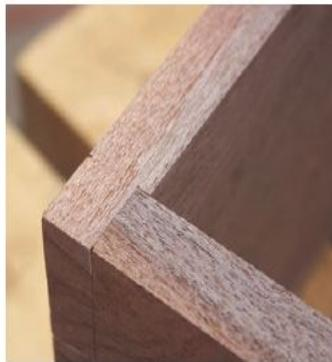
Der kleine Falz an den Enden des Korpusdeckels erlaubt es, die Verbindung durch Profilleisten in voller Materialstärke abzudecken.
