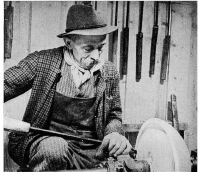
Abb. 349. Meister David Fankhauser beim Ausdrehen der größten Schüssel. — Der Meister schützt seinen Daumen mit einer auf dem Bilde ersichtlichen Umhüllung
