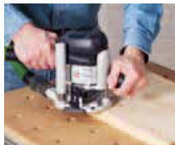
28 Die ersten vier Arbeitsschritte
