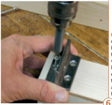
6 > Die Metallprofile werden nun mit 5x60-Schrauben auf dem Kantholz befestigt. Die gegeneinander versetzten Befestigungslöcher sollen verhindern, dass das Holz reißt. Halten Sie beim Aufschrauben ausreichend Abstand zum Hirnholzende.
