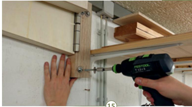
15 > Die Wandhalterung besteht aus stabilem Multiplex, um die Hebelkräfte des voll ausgeklappten Armes sicher aufnehmen zu können. Die Montage erfolgt mit langen Schrauben und Dübeln in das Mauerwerk hinter der hier vorhandenen Wandverkleidung.
