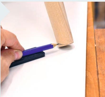
**20** ... waren hier aber nicht nötig. Mit einem Klötzchen unterlegt, zeichnet der Bleistift einen Ring um jedes Bein. Hier wird es dann mit der Handsäge abgetrennt.
